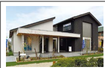
ノイエプラス (壁面トリプル断熱 木造軸組壁工法) ササキハウス TEL.023-633-0007
